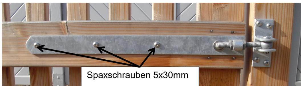
Nun die Tür in die vorgesehene Öffnung stellen, anheben und als Hilfsmittel eine 2-3cm starke Bohle unter die Tür legen (Bodenluft). Als nächstes wird die Tür mit einer Wasserwaage ausgerichtet, dabei auf jeder Seite ca. 1,5cm Luft lassen.
