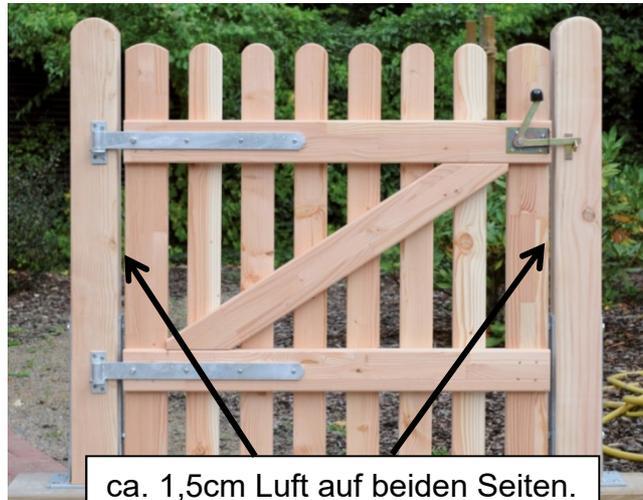
Die Heshaken am Türpfosten so ausrichten, dass die Heshakenplatte bündig mit dem Pfosten abschließt. Danach die Heshakenplatte mit je 4 Stück 5x50mm Spaxschrauben befestigen.
