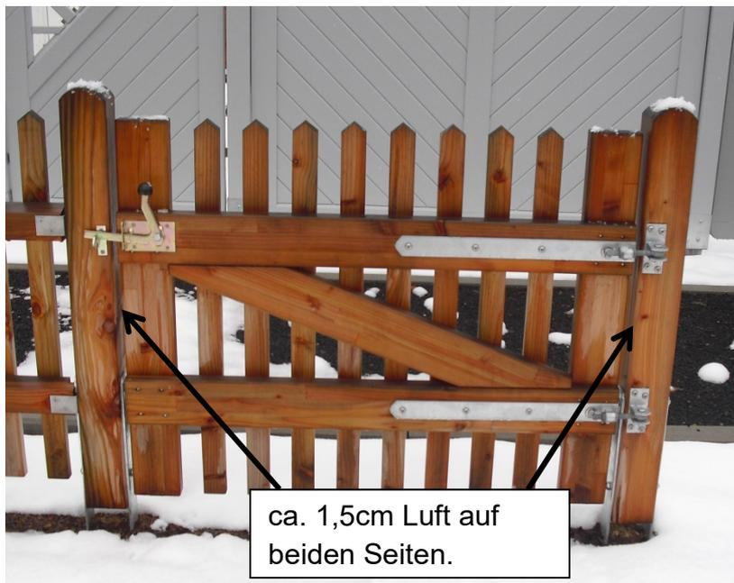
Beim Einbau von den Pfostenankern müssen die Laschen der Anker immer seitlich stehen, sonst können die Heshaken bzw. Bänder nicht an den Pfosten montiert werden (Sichtseite auf das Holz).
