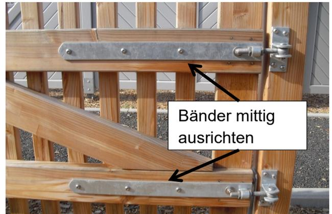
Die äußere Vierkantstanzung mit einem 8mm Holzbohrer durch den Türholm durchbohren und mit den Schlossschrauben 8x80mm befestigen. Hierzu die Schlossschraube mit dem runden Kopf von der Ansichtseite durchstecken (evtl. mit dem Hammer vorsichtig nachhelfen) und von der Bandseite mit der Mutter M8 befestigen. Die anderen drei Bohrungen mit den Spaxschrauben 5x40mm befestigen.
