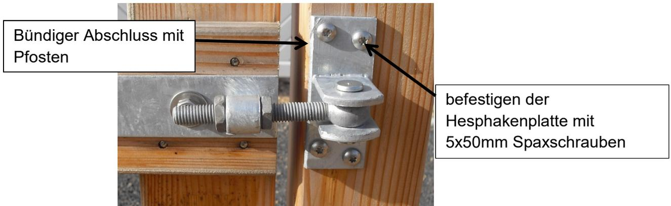
Die Bänder können ausschließlich im eingebauten Zustand verstellt werden um die Tür optimal einzustellen.
