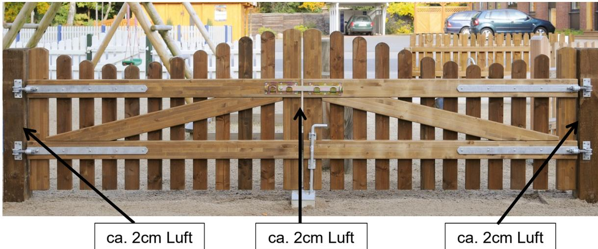
Die Position der Hespaken am Türpfosten festlegen und die Hakenplatte mit je 4 Stück Spaxschrauben 5x50mm befestigen (darauf achten, dass die Tür in Waage ist).
