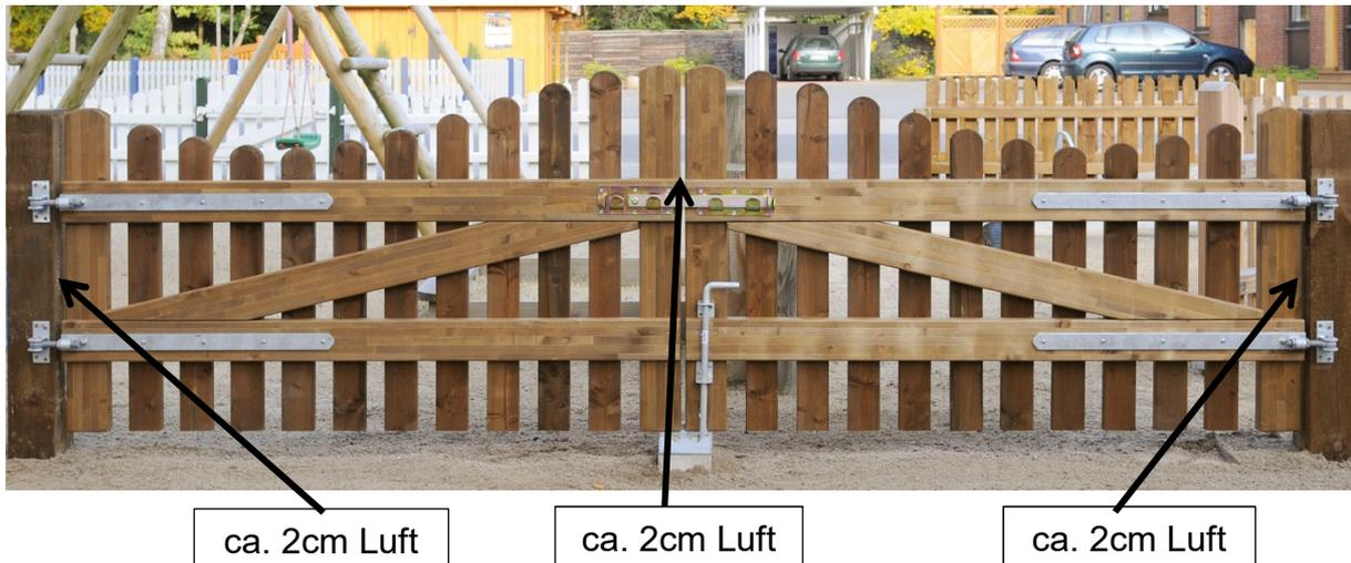
Bei Verwendung von Pfostenankern müssen die Laschen der Anker immer seitlich stehen, sonst bekommen Sie die Hespaken bzw. Bänder nicht am Pfosten montiert.
