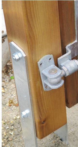
Zuerst werden die vier Winkelbänder mittig ausgerichtet. Diese schließen, bevor die Kröpfung anfängt, mit dem senkrechten Holm bündig ab. Die Winkelbänder werden mit den 28 Spaxschrauben 6x30mm verschraubt.
