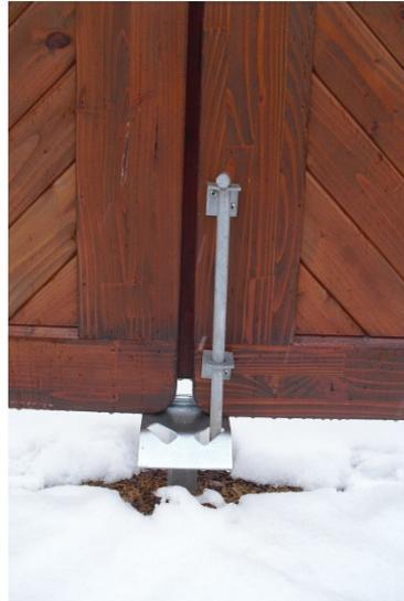
An dem mittleren senkrechten Holm eines Torflügels schrauben Sie den Bodenschieber mit den Spaxschrauben 5x30mm so an, dass der Stab in eine der beiden Öffnungen des Auflaufbocks passt.
