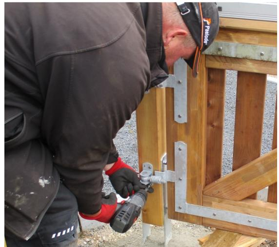
Die Bänder können ausschließlich im eingebauten Zustand verstellt werden um die Tür optimal einzustellen.
