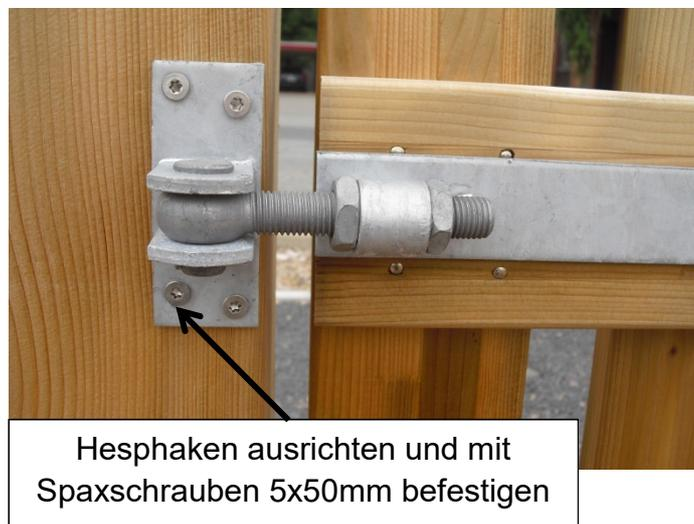
Die Bänder können ausschließlich im eingebauten Zustand verstellt werden um die Tür optimal einzustellen.
