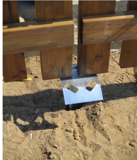
An dem mittleren senkrechten Holm eines Torflügels schrauben Sie den Bodenschieber mit den Spaxschrauben 5x40mm so an, dass der Stab in eine der beiden Öffnungen des Auflaufbocks passt. Eine Halterung wird unterhalb des Querholms befestigt und die andere Halterung oberhalb des Querholms.
