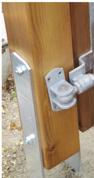
Zuerst werden die vier Winkelbänder mittig ausgerichtet. Diese schließen, bevor die Kröpfung anfängt, mit dem senkrechten Holm bündig ab. Die Winkelbänder werden mit den Spaxschrauben 6x30mm verschraubt.
