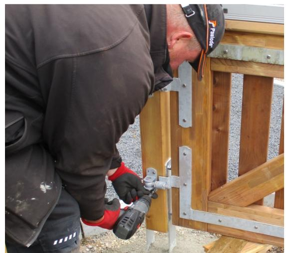
Die Bänder können ausschließlich im eingebauten Zustand verstellt werden um das Tor optimal einzustellen.
