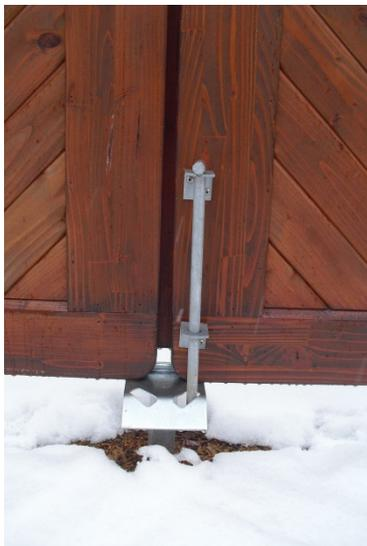
Zum Schluss wird der Rahmentorschieber befestigt. Dieser besteht aus zwei Teilen, dem Schubriegel mit Platte und das Gegenstück. Befestigen Sie die Platte des Schubriegels mit 6 Spaxschrauben 5x35mm an einem der Torflügel. Die Platte sollte mittig am Querholmen und ca. 5 mm von den Senkrechtenholmen ausgerichtet werden.
