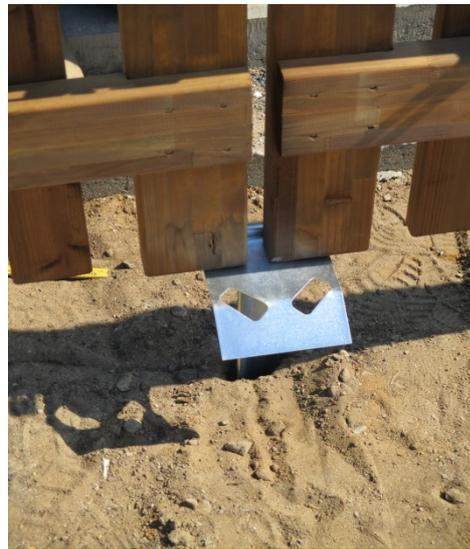
An dem mittleren senkrechten Holm eines Torflügels schrauben Sie den Bodenschieber mit den Spaxschrauben 5x40mm so an, dass der Stab in eine der beiden Öffnungen des Auflaufbocks passt.
