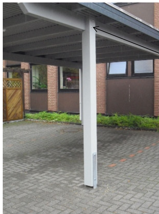
Pfosten-Holm- Verbindung
