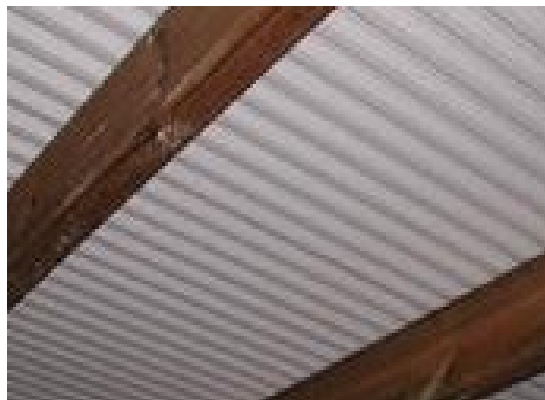
Alu-Trapez-Platte Antitropfbeschichtung (Beschichtung unterseitig)
