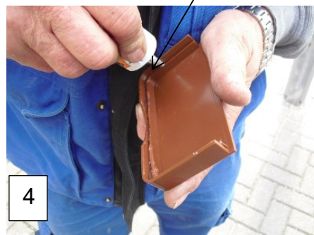
Rinnen-Endboden mit Kleber befestigen
