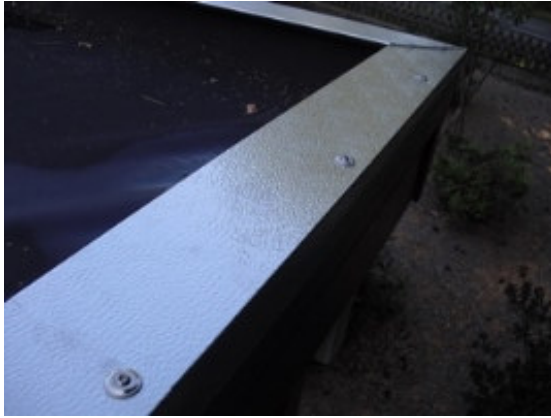
Befestigung der Alu-Blendenabdeckung ca. alle 50cm.
