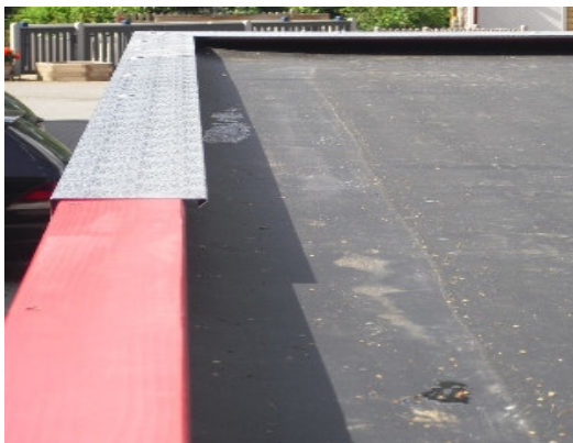
Im Bereich der Carportseiten wird die Blendenabdeckung alle 50cm verschraubt
