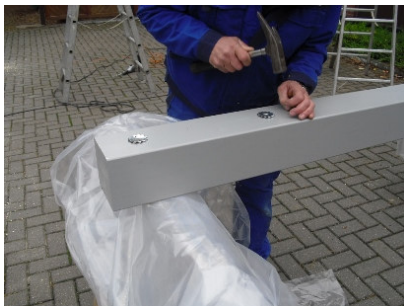
Einseitige Einpressdübel (H-Anker/Pfosten- Verbindung)
