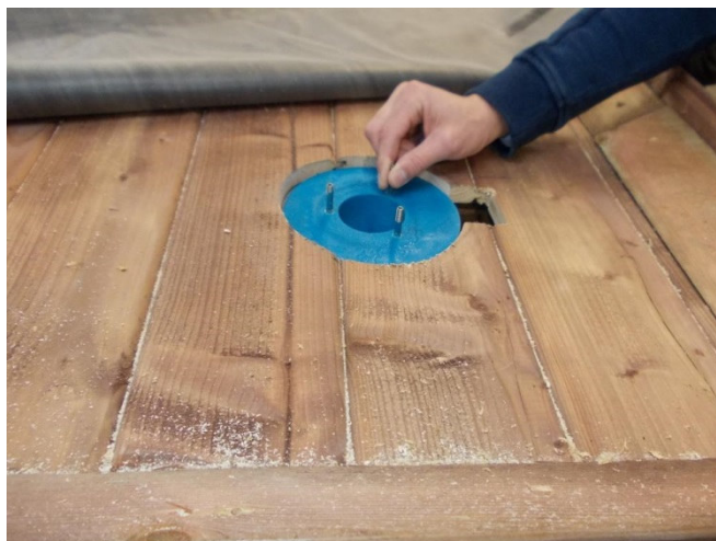
Dachgully mit Stehbolzen M6
