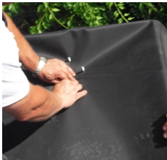
Stehbolzen M6 werden durch die Plane gedrückt
