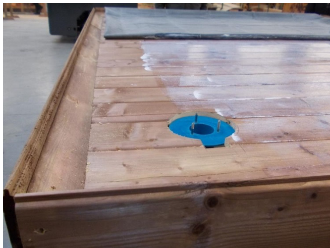
Dachgullymontageplatte 19mm mit 13cm Loch
