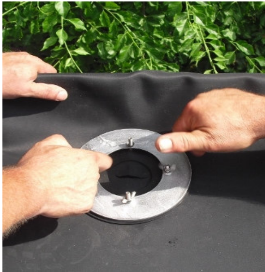
Klemmflansch mit Flügelschrauben befestigen!
