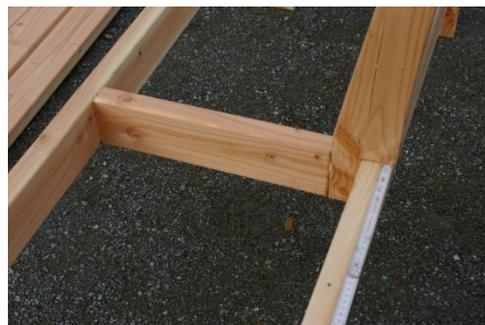
Das hinter Brett der Sitzfläche (G) schließt bündig mit der Rückenlehne (F) oder bei der Bank OHNE Lehne mit der Querstrebe (C) ab. Das vordere Brett der Sitzfläche (G) schließt bündig mit der Querstrebe (D) ab. Diese werden mit den ASSY-Schrauben 5x80mm V2A (H) befestigt. Die anderen Bretter der Sitzfläche (G) werden vermittelt und festgeschraubt (ca. 1,5cm Luft zwischen den Brettern).
