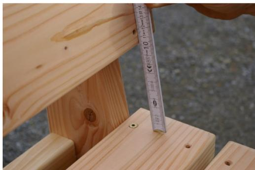
Das mittlere Brett der Rückenlehne (F) mittig ausrichten und mit den Schrauben (H) befestigen (H).
