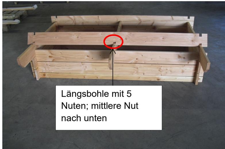
Danach werden 2 Stück Querbohlen (2,8x14,5x99,5cm) und 2 Stück Längsbohlen (2,8x14,5x199,5cm) benötigt. Diese werden wie zu vor in die Nut eingesteckt (als erste die Querbohlen)
