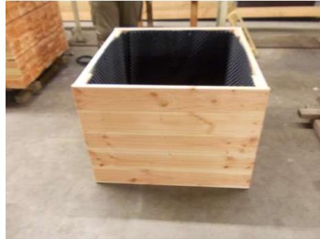
Die Folie am Rand des Kastens bündig abschneiden. Bitte achten Sie darauf auch die Querstrebe mit der Noppenfolie einzukleiden.
