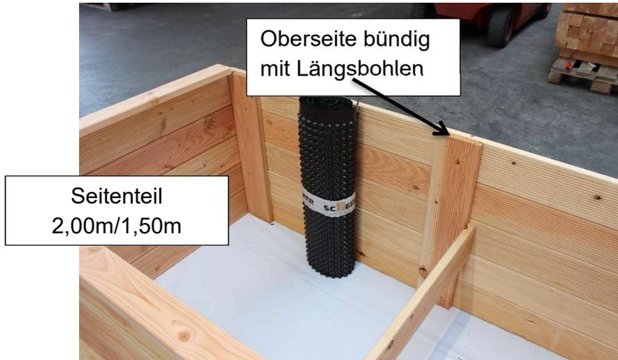
Die Stirnbohlen werden mit je 4 Stück 5x50mm Holzschrauben je Brett von außen an die senkrechten Verbindungsbohlen der Seitenteile geschraubt. Die Schrauben werden so gesetzt, dass sie in die senkrechten Verbindungsbohlen eingedreht werden, nicht in das Hirnholz.
