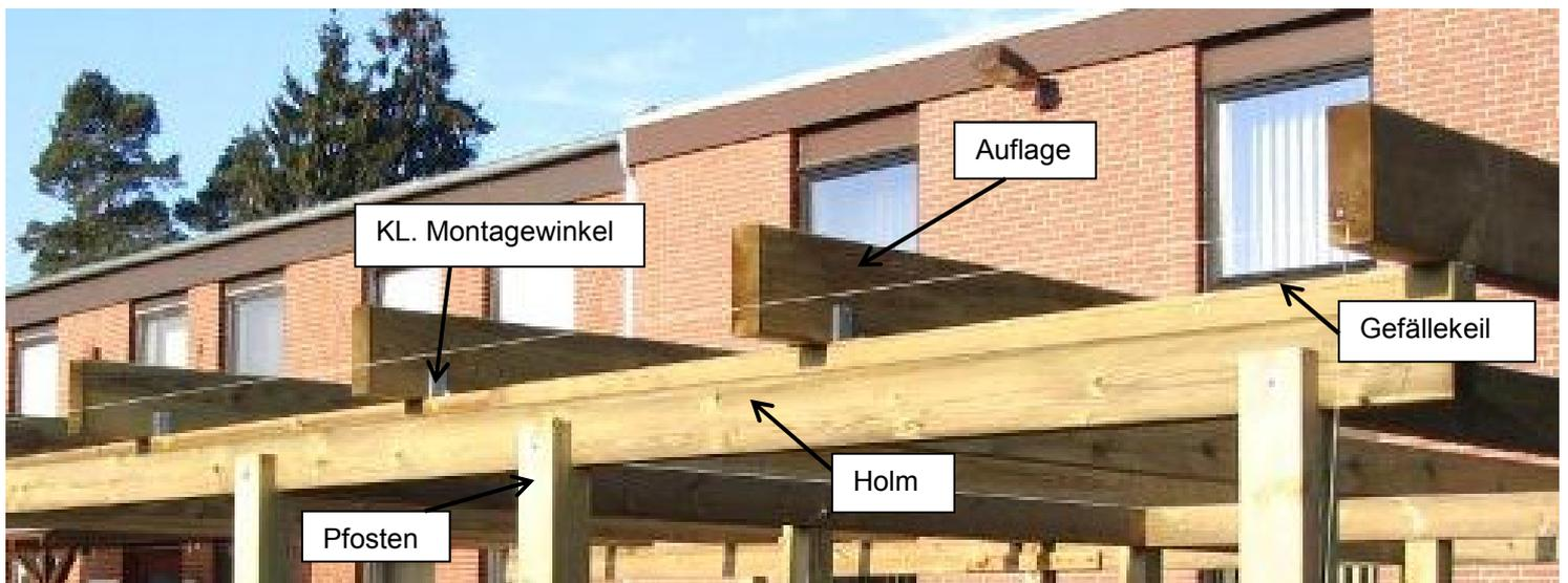
• Mit den Auflagen komplettieren Sie das Gerüst. Jetzt sieht man schon genau, wie es aussehen wird, wenn alles fertig ist.
