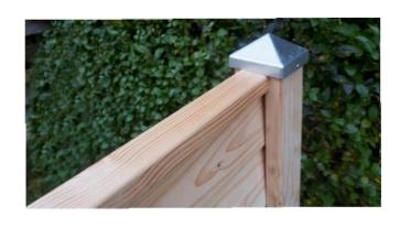
Fixieren Sie jedes Brett mittig mit einer Schraube von 3,5x55mm. Diese werden seitlich schräg in die Nut geschraubt. Auf das oberste Brett kommt die Abdeckleiste 3x5cm. Diese ist mit 200cm etwas länger. Einfach maßgerecht anpassen und von oben festschrauben (vorbohren).
