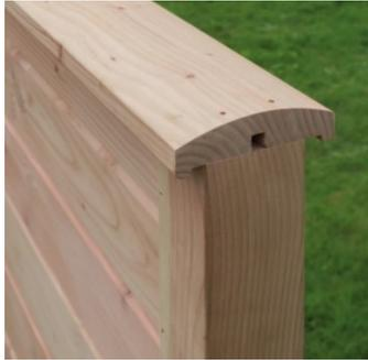
Zum Schluss wird die Abdeckbohle 40x140mm oben auf die Pfosten montiert. Diese hat eine Länge von 225cm und muss angepasst werden. Zum Festschrauben (Vorbohren!) eignen sich Edelstahlschrauben 4,5x60mm.
