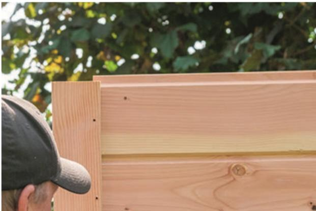
Richten Sie die Bohlen so aus das die Feder des obersten Brettes ca. 10mm über die Pfostenkante übersteht (siehe Foto).
