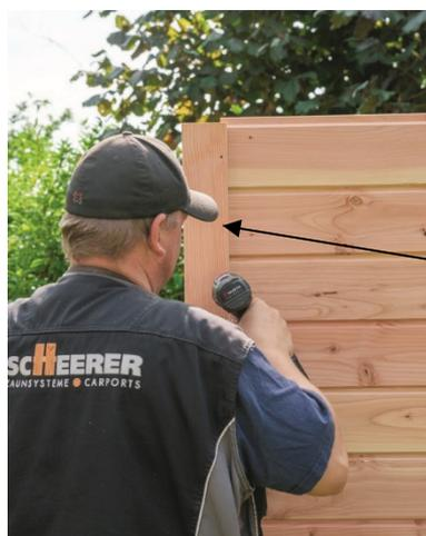
Nun fixieren Sie jede Bohle mittig, auf jeder Seite mit einer Edelstahlschraube von ca. 3,5x50mm.
