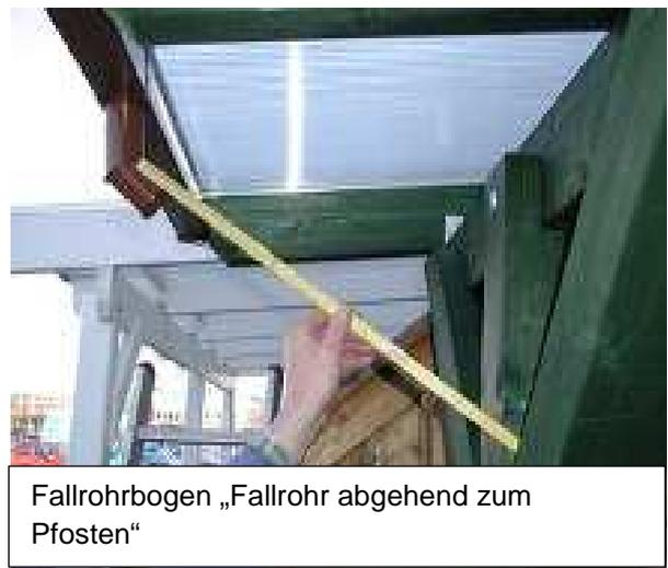
Fallrohrbogen „Fallrohr abgehend zum Pfosten“
