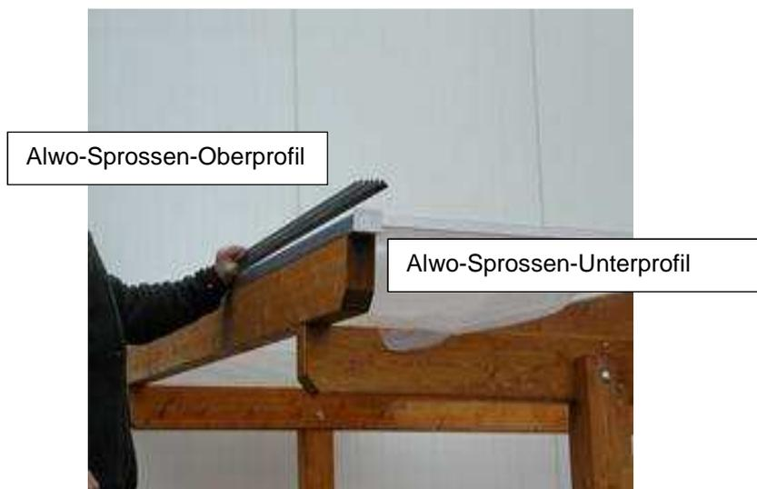
Die Schrauben dürfen nicht überdreht werden, deshalb nicht mit „Schlagschrauben“ arbeiten. Es dürfen nur die zum System gehörenden Klemmschrauben verwendet werden, da sonst die Ausreißfestigkeit nicht gewährleistet ist.
