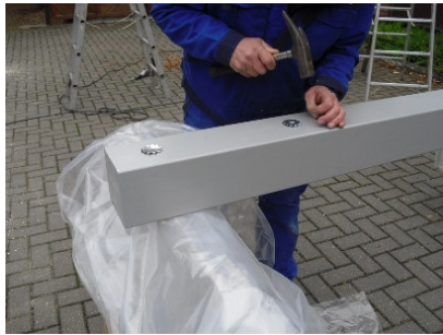
Einseitige Einpressdübel (H-Anker/Pfosten- Verbindung)
