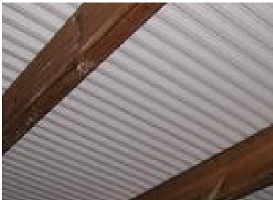
Alu-Trapez-Platte Antitropfbeschichtung (Beschichtung unterseitig)
