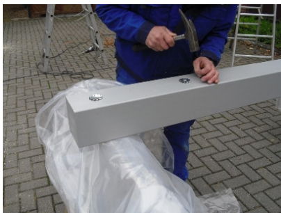
Einseitige Einpressdübel (H-Anker/Pfosten- Verbindung)
