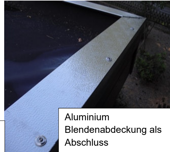
Obere Lage „Polymer- Bitumenbahn Hassodritt“
