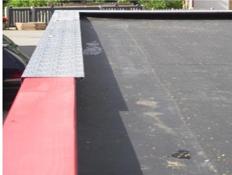
Im Bereich der Carportseiten wird die Blendenabdeckung alle 50cm verschraubt
