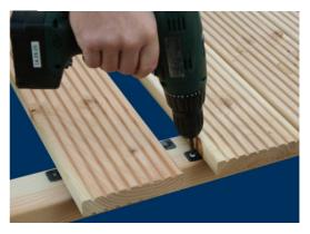
3. Am Anfang und am Ende der Terrasse wird die Lasche des Halters umgeschlagen und an der Stirnseite der Unterkonstruktion festgeschraubt. Alternativ kann man die überstehende Lasche auch absägen und die Bohle sichtbar von oben verschrauben.
