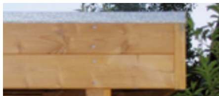
Umlaufende Blendenabdeckung aus Aluminium Stucco blank als Ergänzung für Flachdach-Holzblende.
