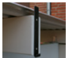
Verdeckte Blendenbefestigung. Mit unserer Befestigung erhalten Sie eine schraubenfreie Blendenoberfläche.
