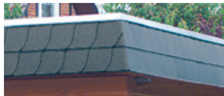
Walblende, komplett mit zwei Reihen Schindeln 20 x 20 cm mit Bogenschnitt und Alu-Abdeckung Stucco blank 123 x 45 mm.
