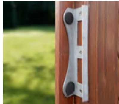
Einbau des Anschlagwinkels bei Toren Gehflügel DIN-links
