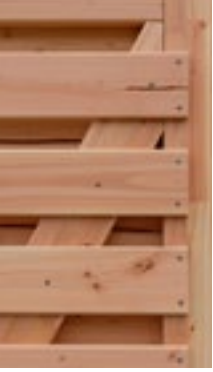
Borkum Tür, Verschraubung, Innen- bzw. Außenansicht
