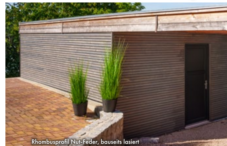
Rhombusprofil Nut-Feder, bauseits lasiert
