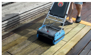
Reinigung der Terrassenoberflächen mittels Bürstmaschine.
