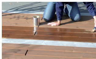
Pflege und Wartung von Oberflächenbeschichtungen
