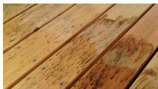
Wasserlösliche Gerbstoffe reagieren bereits beim Kontakt mit minimalen Eisenkonzentrationen. Diese Reaktionen führen zu graublauen bis schwarzen Verfärbungen.
